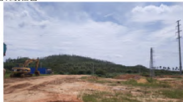
拟建项目地块南部（南向）
