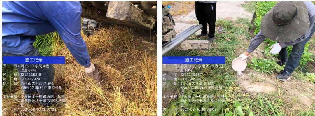
图 4.7-1 现场调查环境保护措施（封孔）
