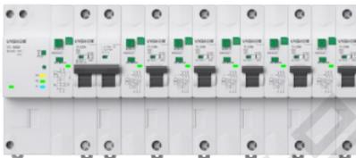
6.3.2 Y3系列智慧通讯模组(4G)启动后,“RUN”指示灯亮起并闪烁,约1分钟之后,智慧通讯模组启动成功,“RUN”指示灯由闪烁变为常亮;有断路器模组连接的情况下,“BUS”指示灯闪烁,表明总线通讯成功;有4G网络数据通讯时,“4G”指示灯闪烁。
