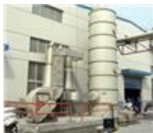
图 4.18 工业用有机尾气活性碳纤维吸附回收装置
