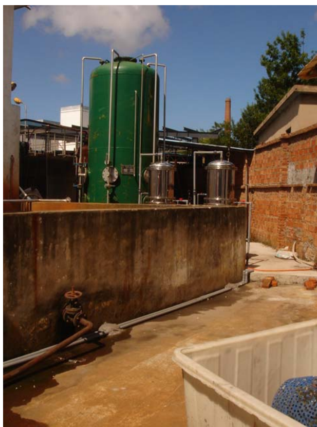
图 4.3.2.4 工程现场图（复合反应器）
