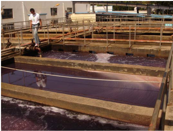
图 4.3.2.2 工程现场图 (生化部分)
