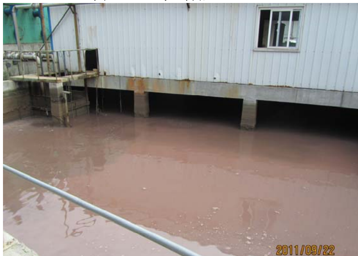
图 4.3.5.3 5000 吨/天工程调节池（原水）
