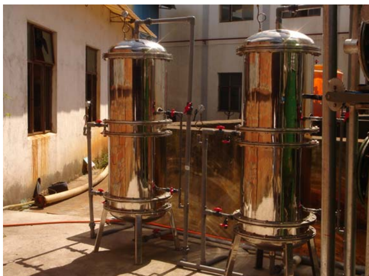
图 4.3.2.3 工程现场图（陶瓷膜部分）
