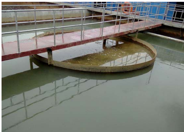
图 4.3.5.4 5000 吨/天工程絮凝池
