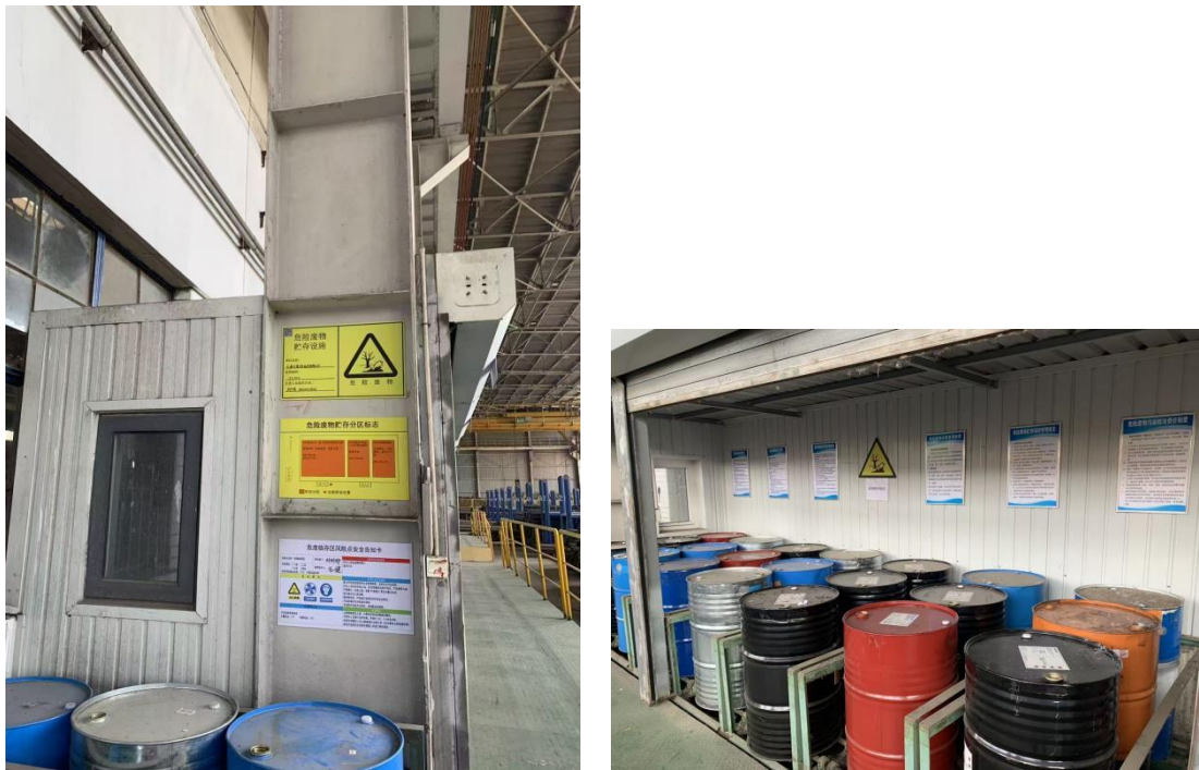
图 2.4-2 现有工程危险废物暂存间图
