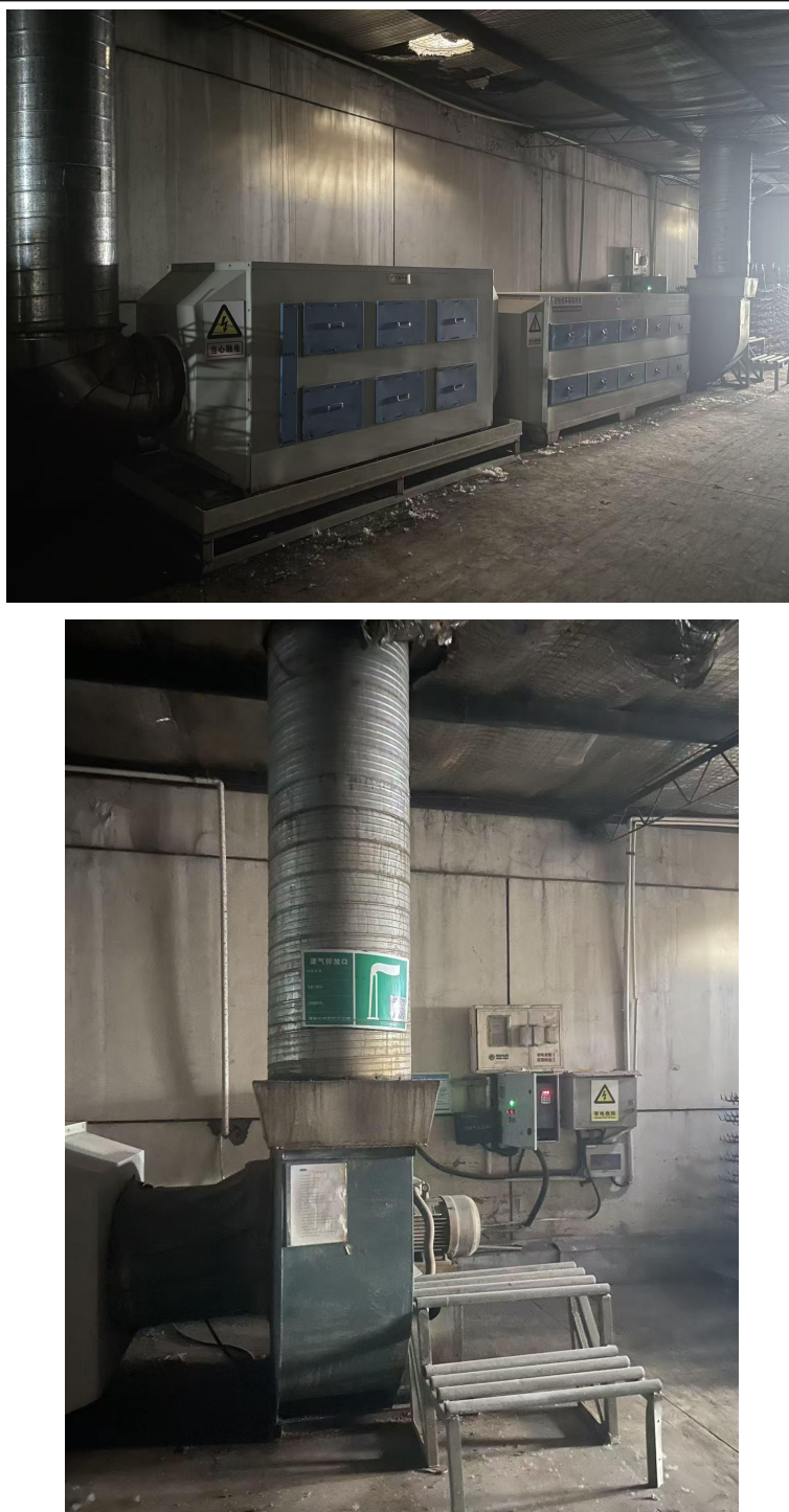
图3 现有 P2 排气筒净化设施及其标识牌
