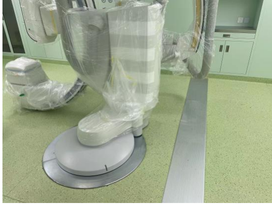
电缆沟铅屏蔽盖板
