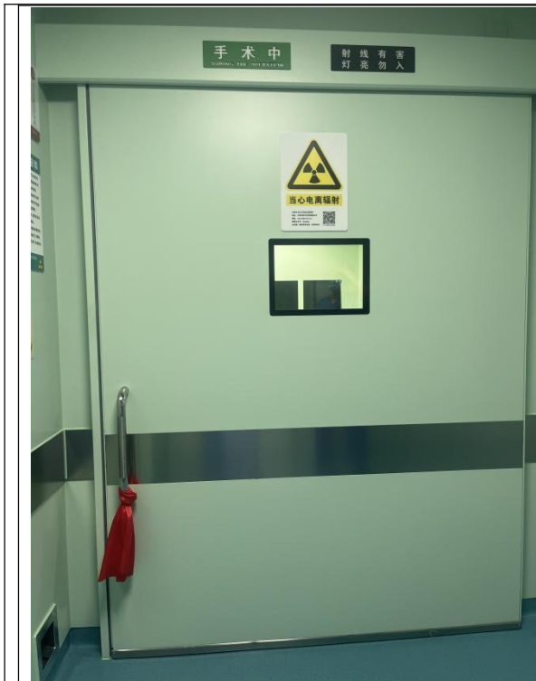
DSA手术室辐射工作人员、受检者进出门工作状态指示灯及电离辐射警告标志
