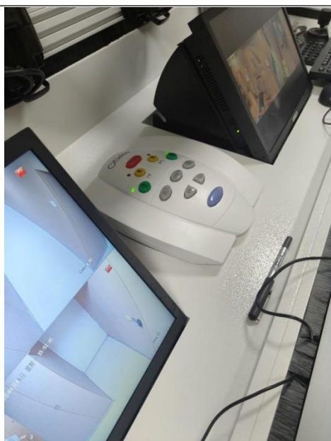
控制室监控及急停控制按钮
