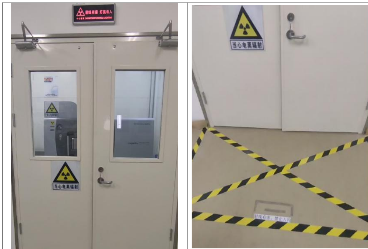
CT 操作间门上工作状态指示灯、当心电离辐射警告标志等
