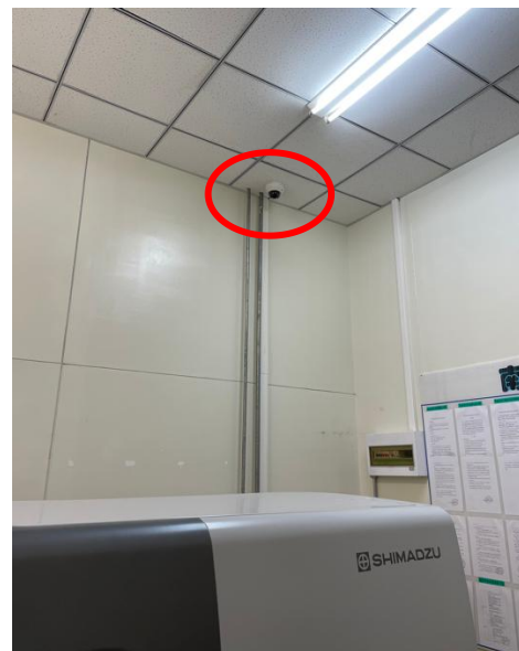
CT 操作间室内摄像头
