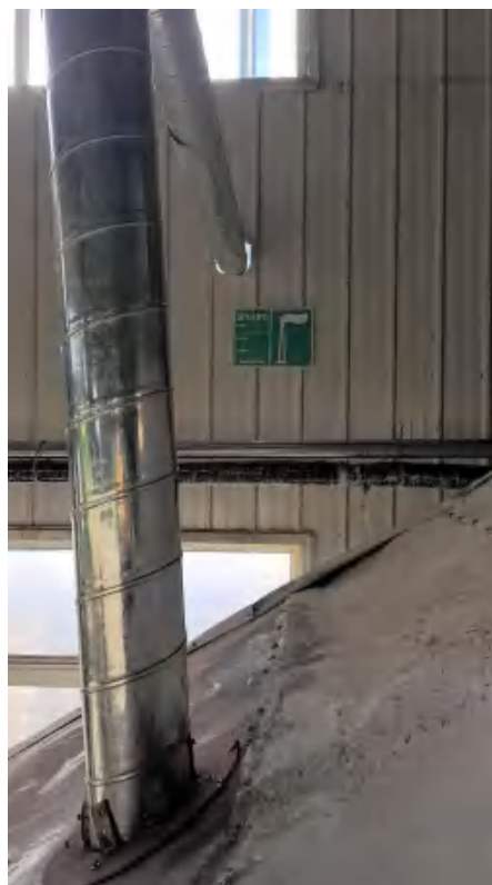
图 16 排气筒 P3 检测孔及规范化标识牌照片
