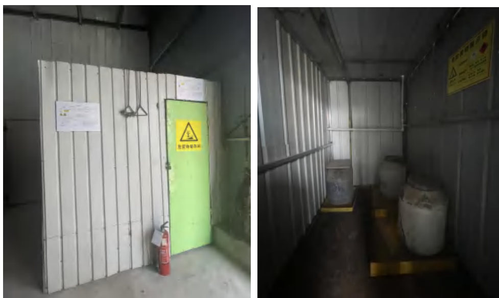
图 18 危险废物暂存间照片
