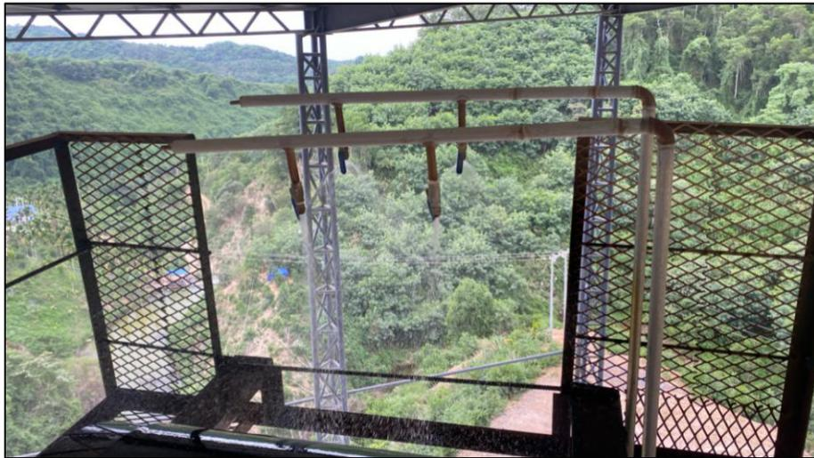
图 1.2-21 砂石料加工系统粗碎车间喷淋系统
