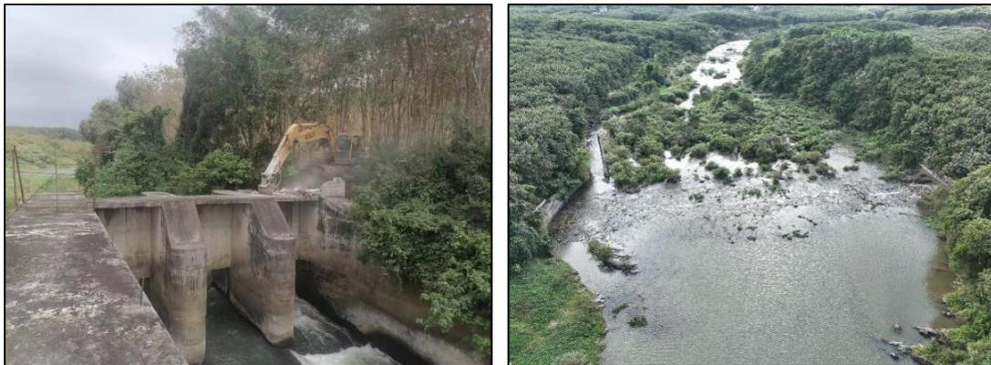
图 4.2-4 同兴电站拆除
