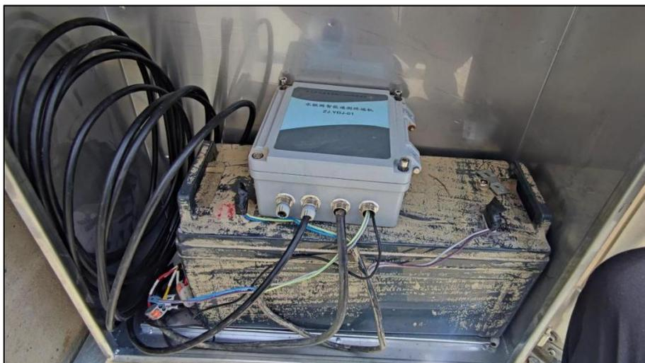
图 1.2-4 坝上站水联网智能遥测终端机
