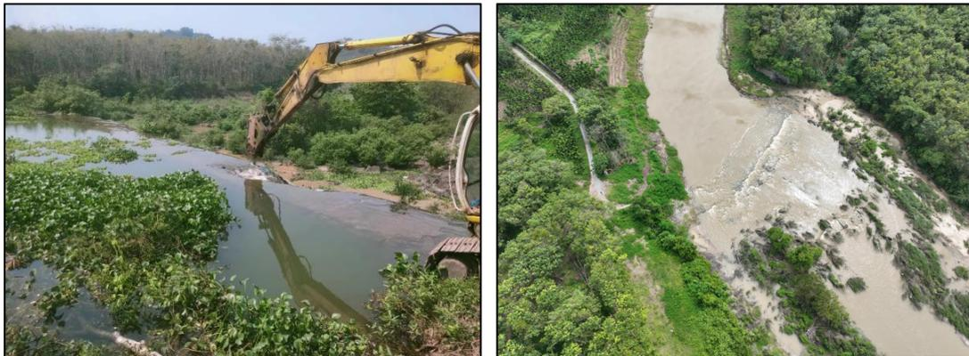
图 4.2-3 阳江二级电站拆除
