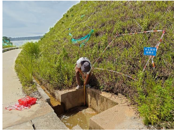
左岸边坡排水沉积泥沙观测点
