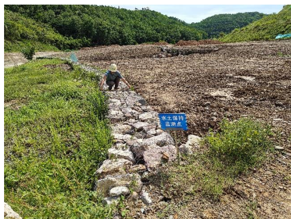
2#弃渣场水保措施实地量测
