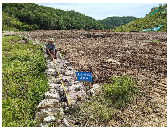
2#弃渣场水保措施实地量测
