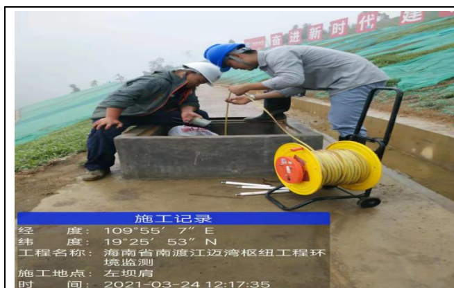
左坝肩地下水水位现场监测
