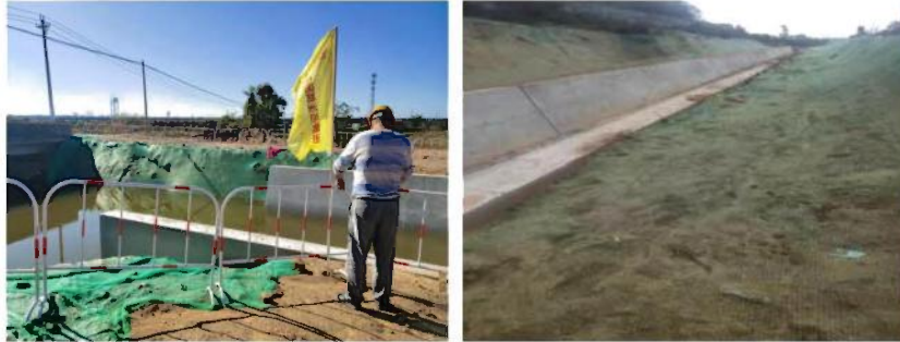
施工作业面地表裸露临时防护
