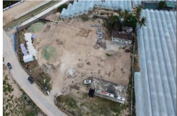
位置：西干渠管理所 拍摄日期：2021.4.9
