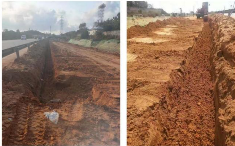
施工道路区临时排水
