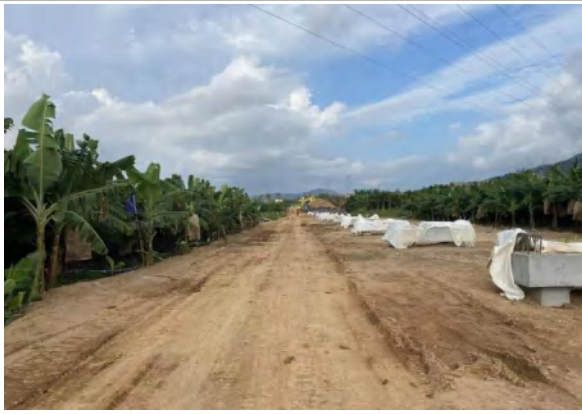
位置：大隆东干渠 K9+400 拍摄日期：2021.10.20
