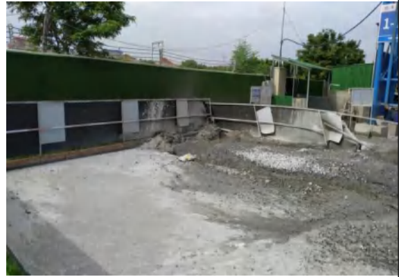
位置：乐东片 1#拌合站沉淀池 拍摄日期：2020.9.16
