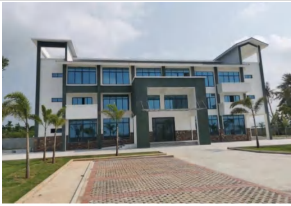
位置：西干渠管理所 拍摄日期：2022.3.23
