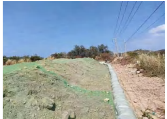
位置：乐东片临时堆土场区 拍摄日期：2021.6.13
