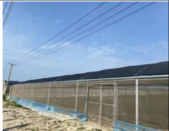
位置：乐东片区临时堆土场（已整地复耕） 拍摄日期：2022.3.9
