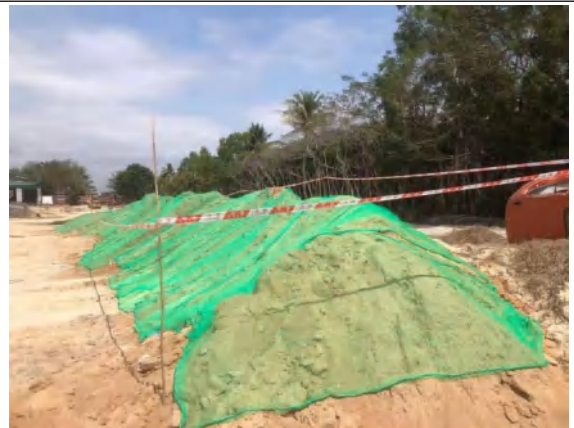
位置：三亚片临时堆土场区 拍摄日期：2021.6.15
