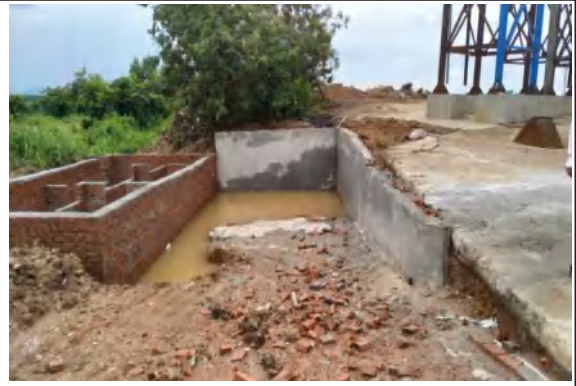
位置：乐东片 2#拌合站沉淀池正在施工 拍摄日期：2020.9.16
