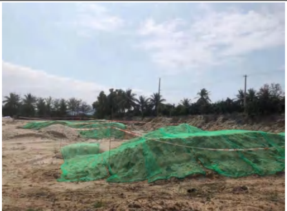
位置：三亚片临时堆土场区 拍摄日期：2021.4.11
