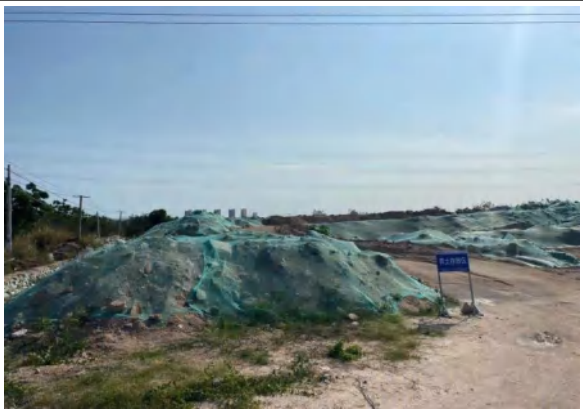
位置：乐东片临时堆土场区 拍摄日期：2021.4.21
