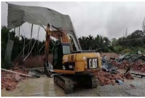
位置：乐东片 1#拌合站正在做拆除工作 拍摄日期：2021.6.25
