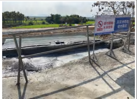
位置：乐东 2#拌合站沉砂池 拍摄日期：2022.3.23
