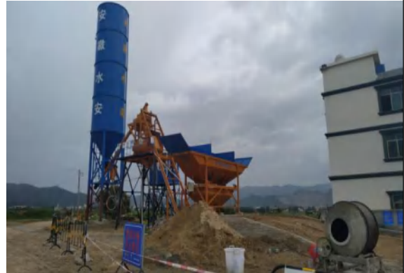
位置：三亚片 1#拌合站正在施工 拍摄日期：2020.9.17
