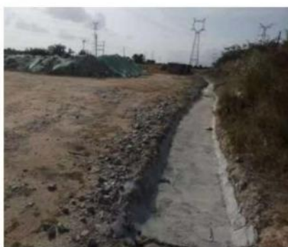
临时堆土场排水措施
