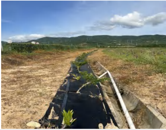
位置：大隆续建段 拍摄日期：2023.6.28
