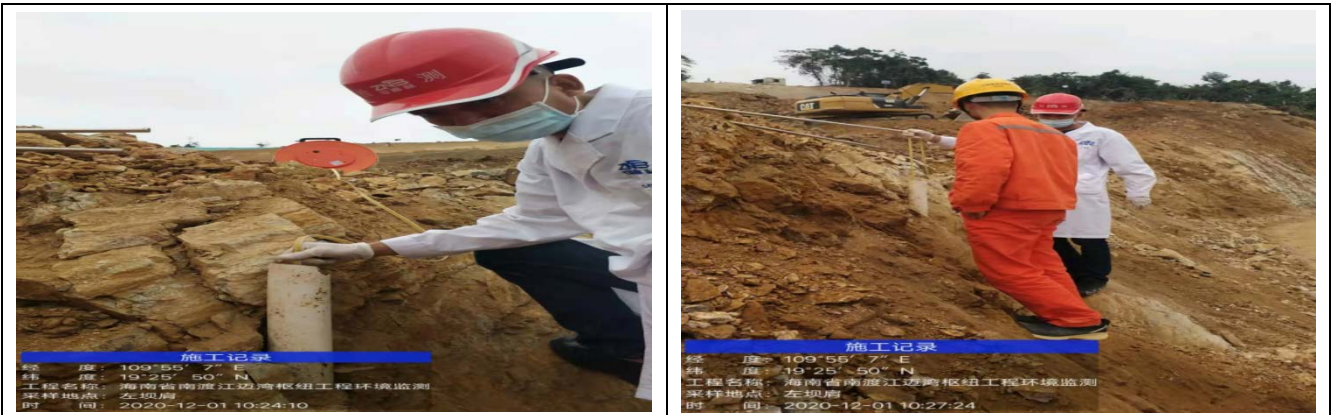
左坝肩地下水水位现场监测
