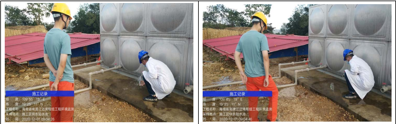
施工区供水站水池饮用水水质采样
