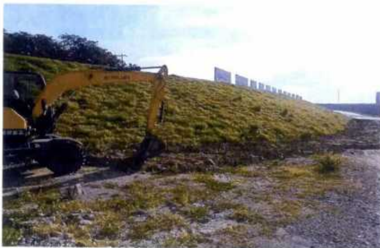
图6 总干渠坡脚施工
