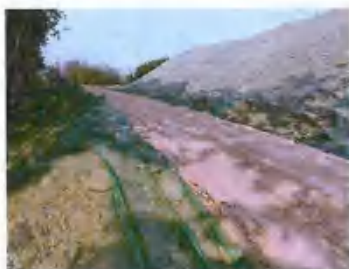
渣场增设马道及边坡苫 大坝上游左右岸坡削坡并增设马道
