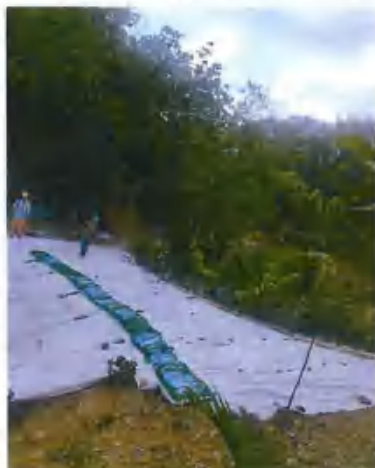
2#渣场临时挡墙
