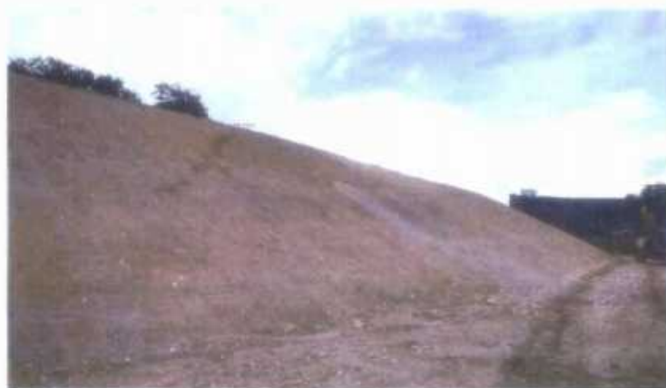
图 1 未植草前的总干渠左岸边坡
