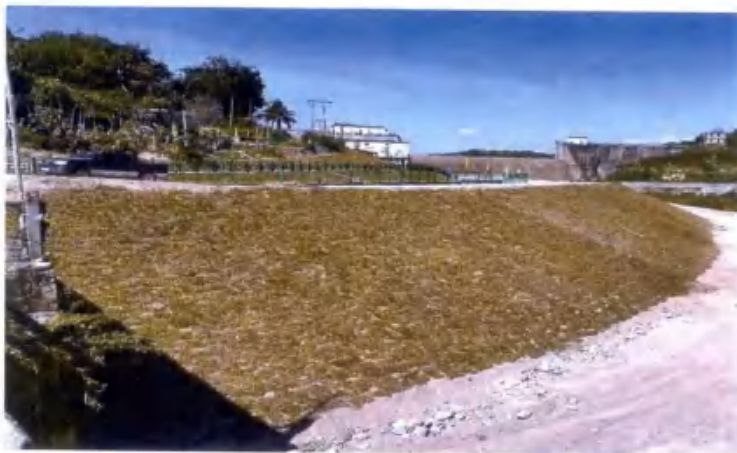
图2 进行植草后的总干渠左岸边坡
