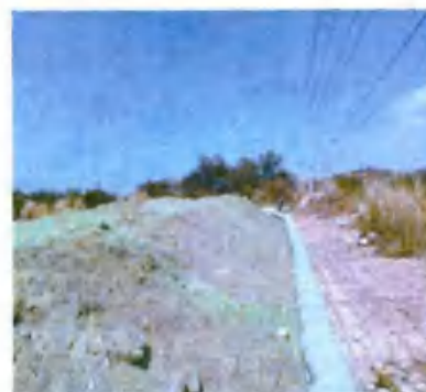
临时堆土场临时拦挡措施
