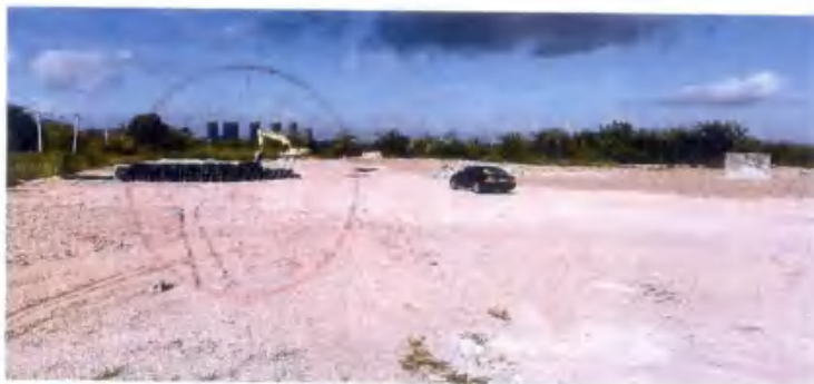
图9 堆土已转运回填并完成土地整治
