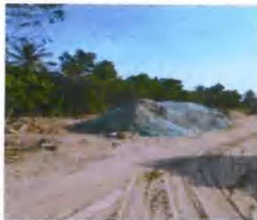
三亚片临时堆土场密目网覆盖 三亚片临时堆土场整平清理
