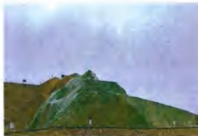
渣场增设马道及边坡苫 大坝上游左右岸坡削坡并增设马道
