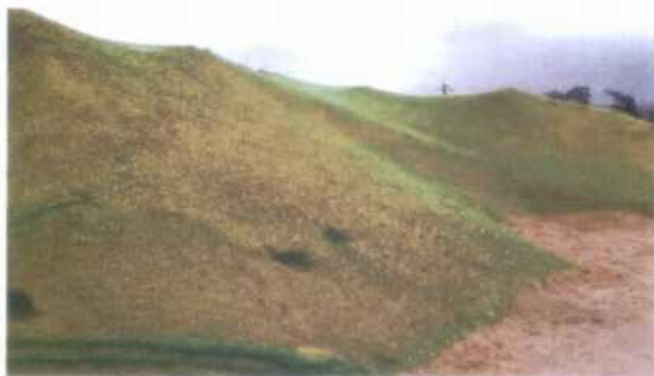
图7 施工表土堆放区（已苫盖保护）
