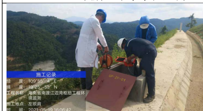
2021.05.19 左坝肩地下水水位监测
