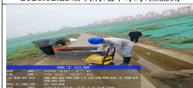
2021.03.24 左坝肩地下水水位监测
