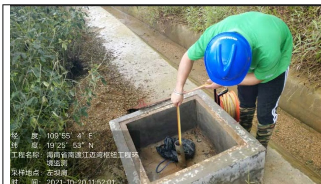
2021.10.20左坝肩地下水水位监测
