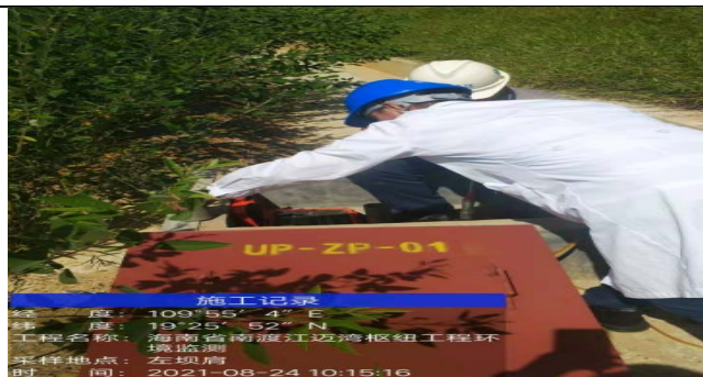
2021.08.24左坝肩地下水水位监测
