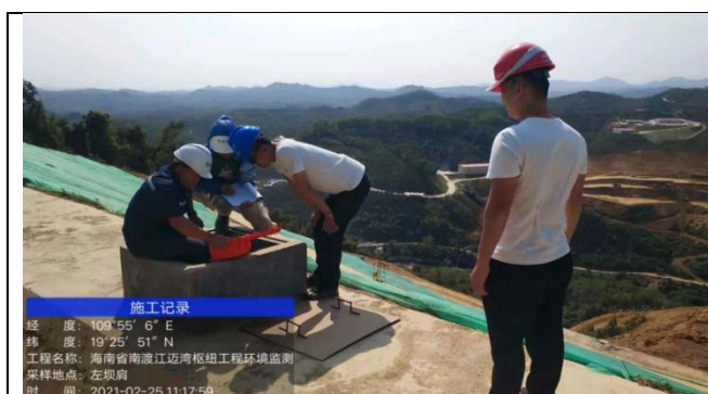
2021.02.25左坝肩地下水水位监测
