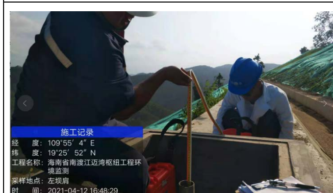
2021.04.12左坝肩地下水水位监测
