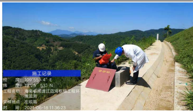
2021.06.18左坝肩地下水水位监测
