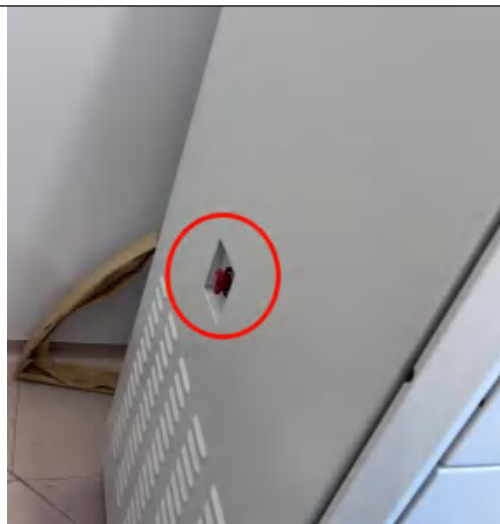
直线加速器电箱急停开关
