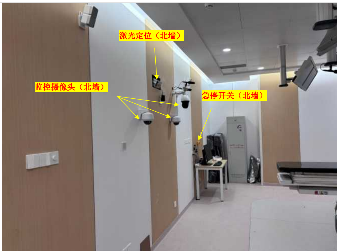
3 号直线加速器机房北墙安全装置
