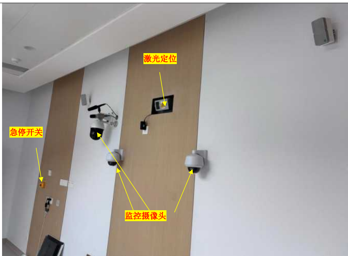
4 号直线加速器机房北墙安全装置
