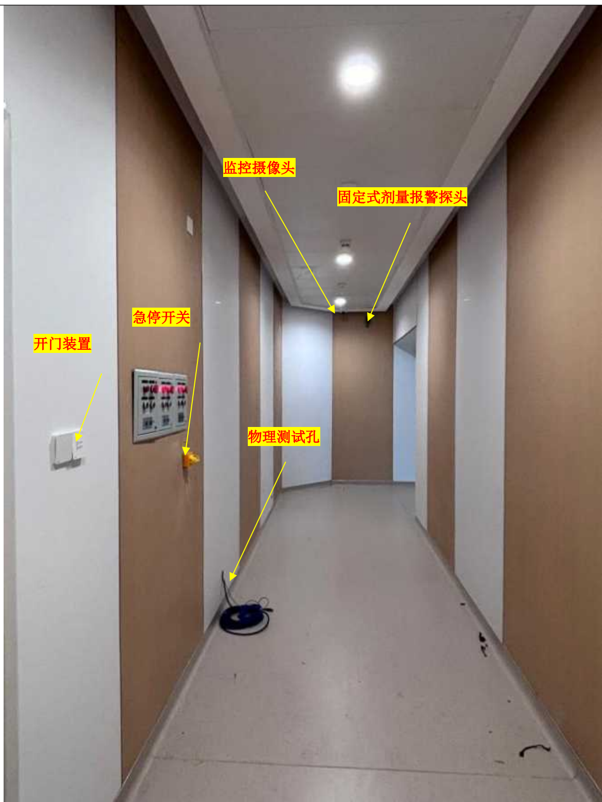
4号直线加速器机房迷道安全装置
