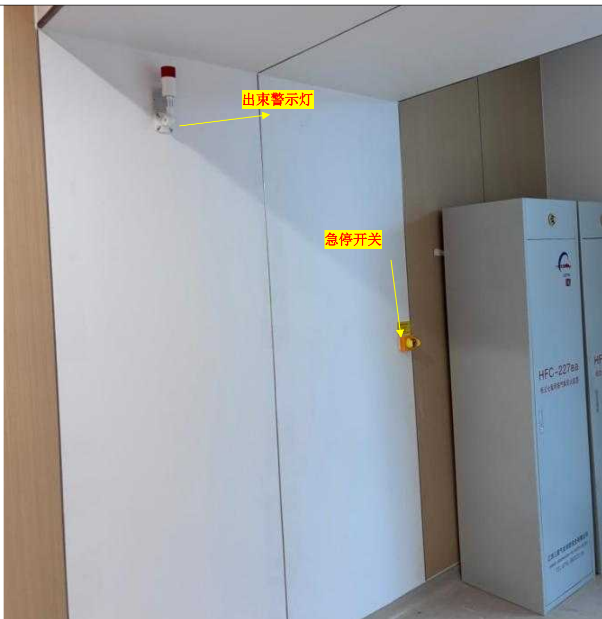
4 号直线加速器机房迷道内入口安全装置
