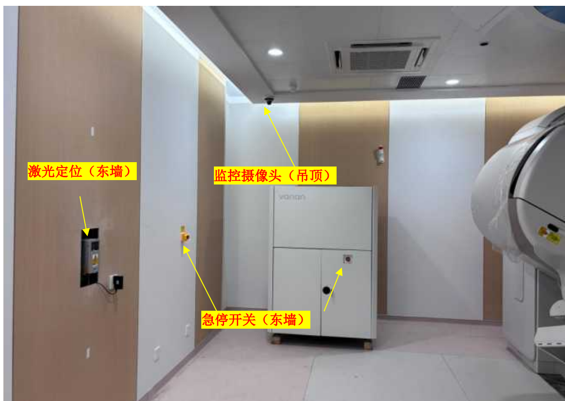
3 号直线加速器机房东墙安全装置
