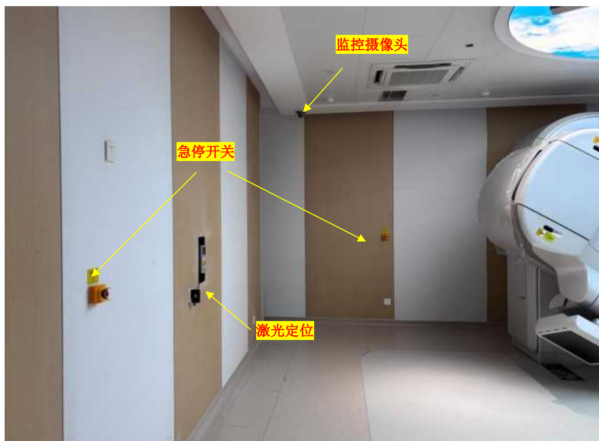
4 号直线加速器机房东墙、南墙安全装置
