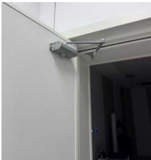
操作室防护门自动闭门装置
