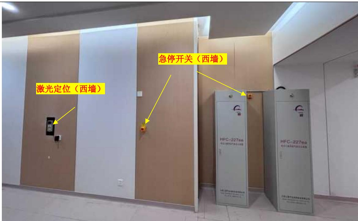
3号直线加速器机房西墙安全装置
