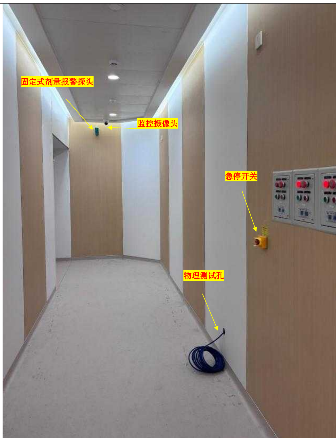
4号直线加速器机房迷道安全装置
