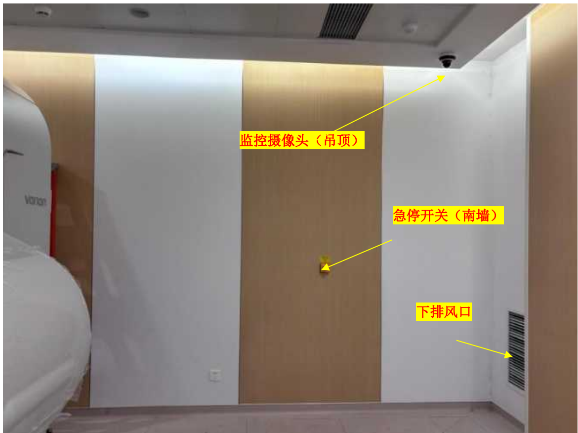
3号直线加速器机房南墙安全装置
