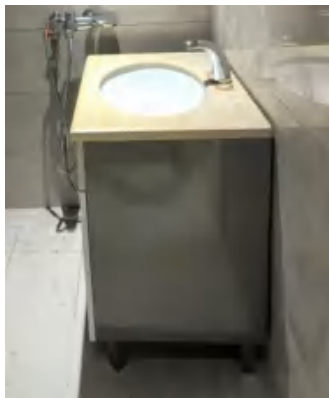
自动感应出水洗手盆（去污淋浴间）
