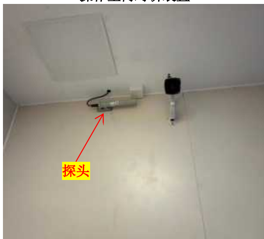
迷道内入口固定式报警仪探头
