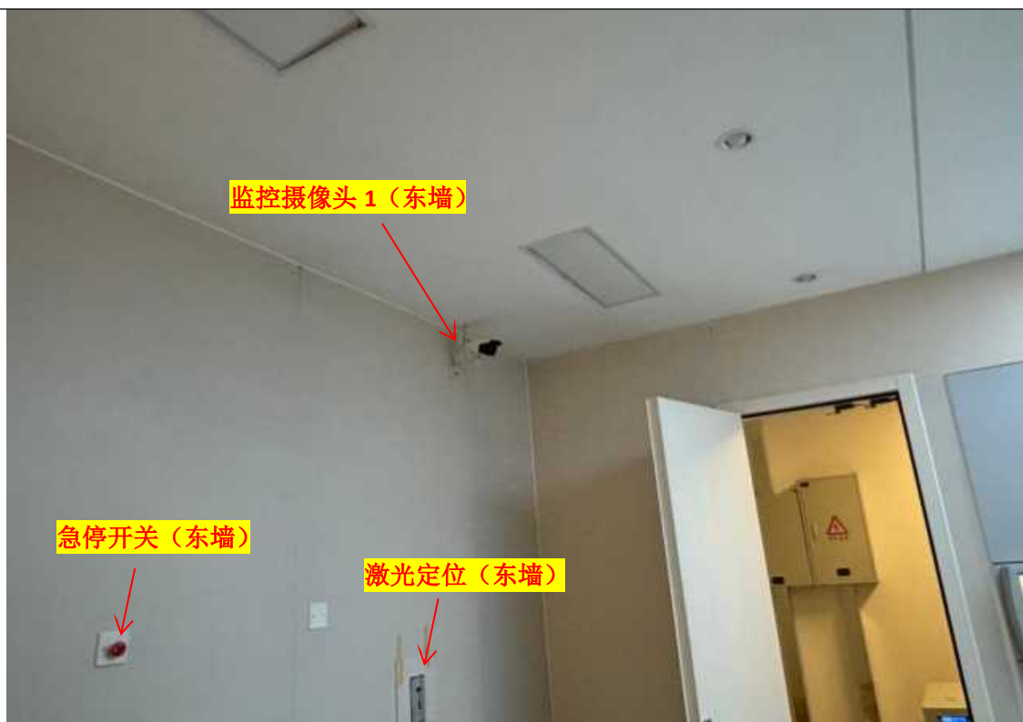
治疗室东墙的急停开关、监控摄像头 1、激光定位装置
