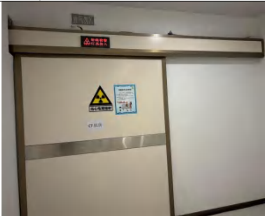
机房大门关门状态
