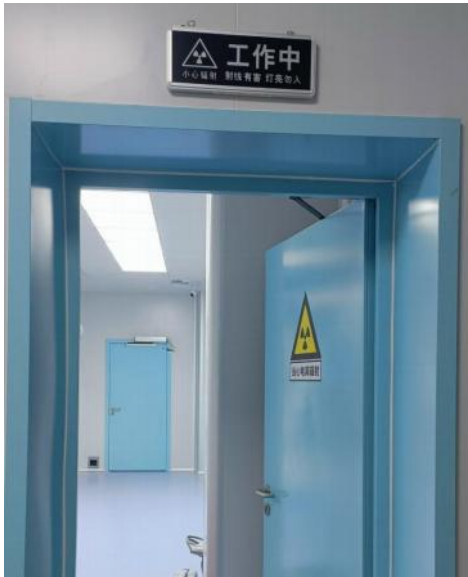
控制室门（闭合）
