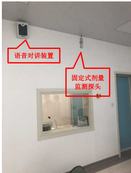
语音对讲装置和辐射监测探头
