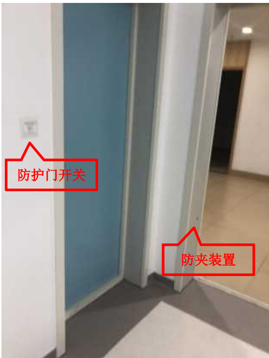
治疗室内机房大门开关和防夹感应装置
