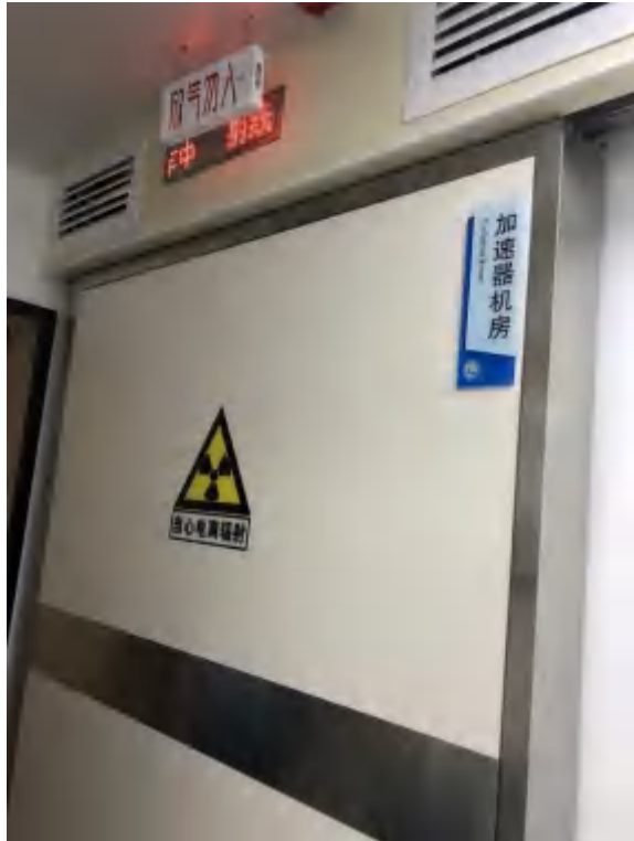
回旋加速器机房入口（关门状态）
