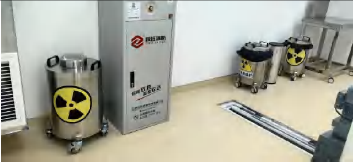
回旋加速器机房废物桶（共 3 个）
