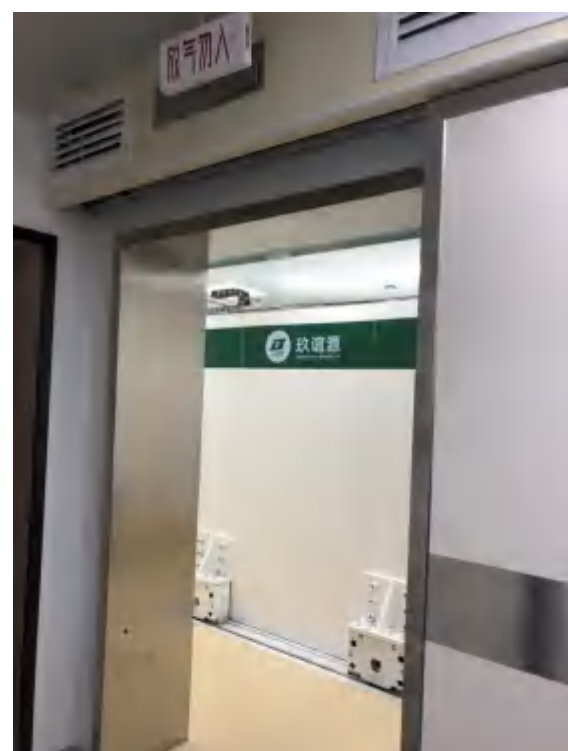
回旋加速器机房入口（开门状态）
