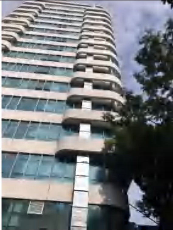
室外排风立管
