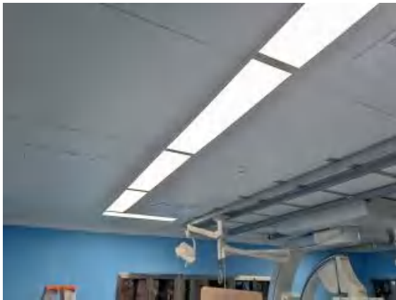
DSA4 室排风口照片
