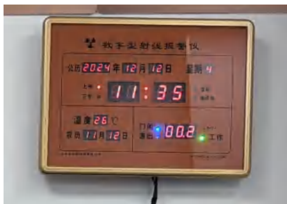
4号直线加速器机房 操作室固定式报警仪显示面板
