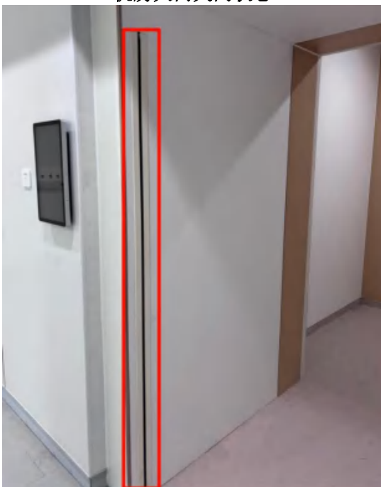
3 号直线加速器机房 防护门防挤压装置
