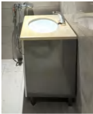
自动感应出水洗手盆（去污淋浴间）
