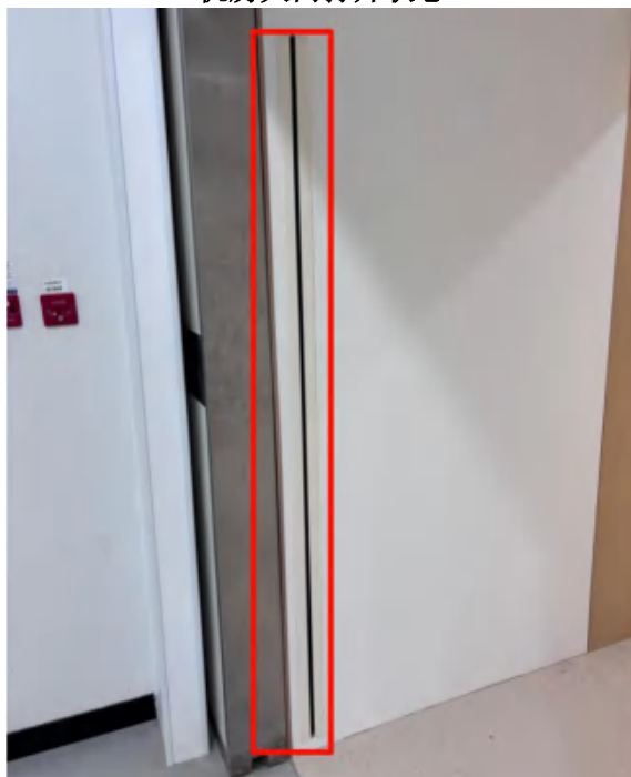
4 号直线加速器机房 防护门防挤压装置
