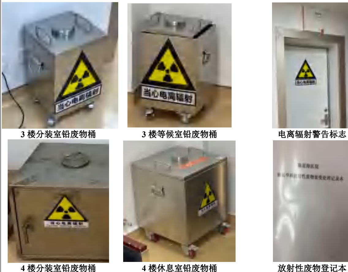
图 3-7 放射性固体废物的放射防护措施现场照片
