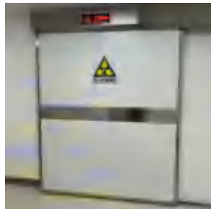
机房大门关闭情况
