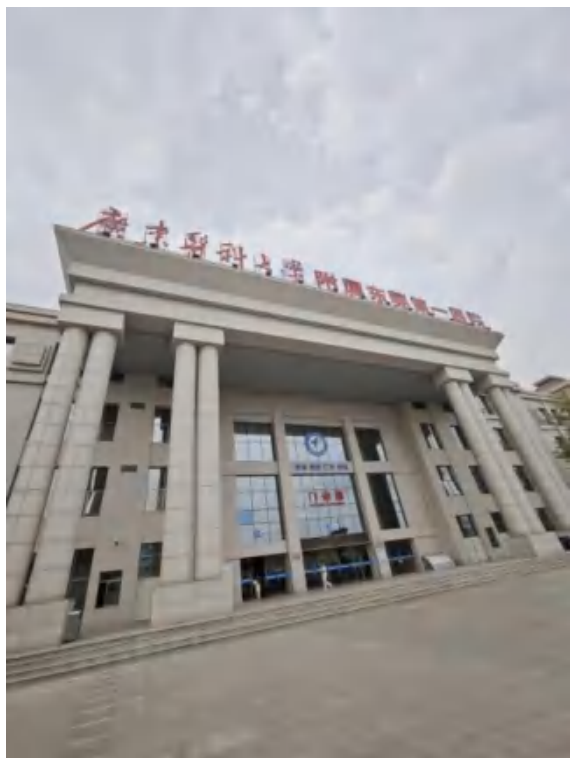
本项目所在门诊医技楼
