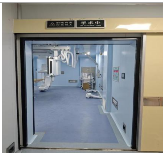
机房大门闭合状态
