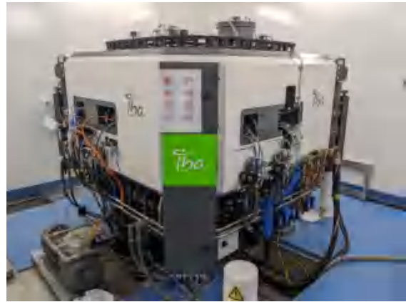
D 栋负一层回旋加速器现状
