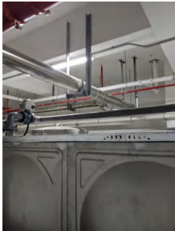
D 栋负二层一体化衰变池
