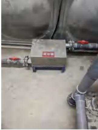
D 栋负二层取样槽
