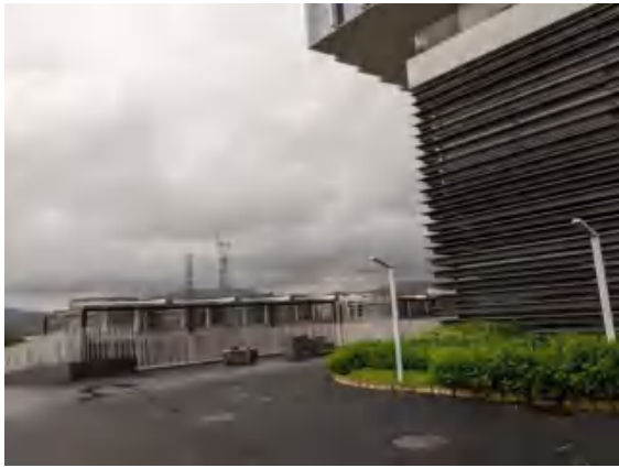
项目西北侧园区内道路
