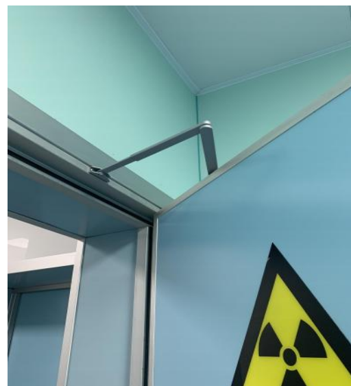
污物通道门及自动闭门装置
