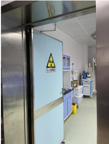
控制室防护门
