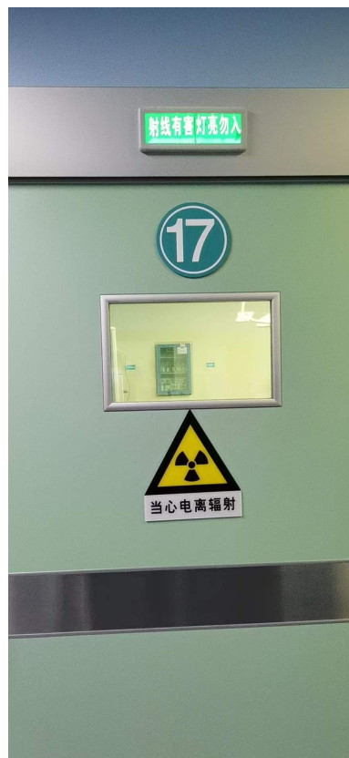
住院楼十三楼手术室17（关门状态）
