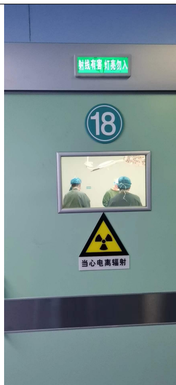
住院楼十三楼手术室18（关门状态）
