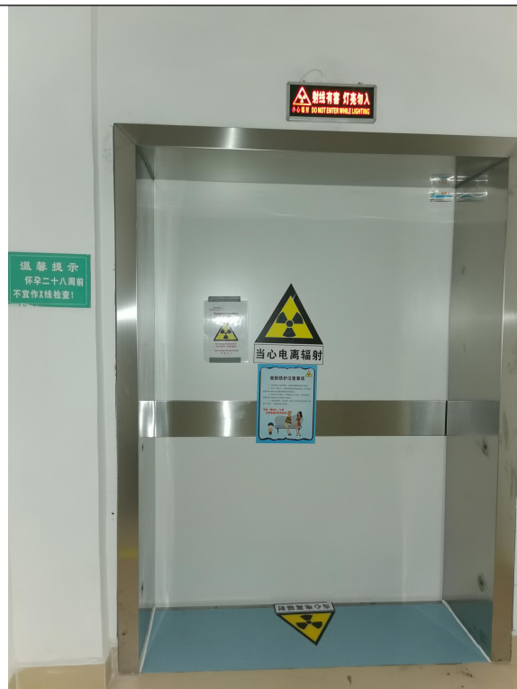
医技楼一楼介入1室（关门状态）
