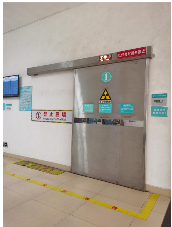
医技楼一楼照片室（1）（关门状态）
