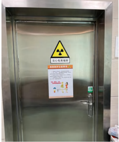
操作室门辐射警告标志
