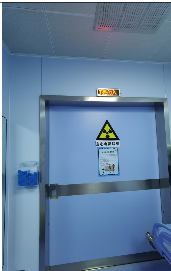
DSA机房大门（关门状态）
