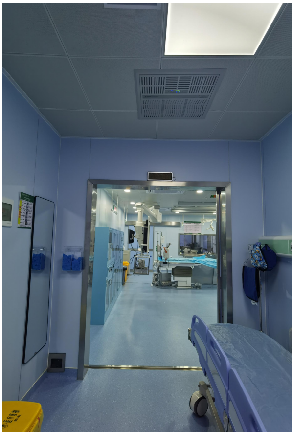
DSA机房大门（开门状态）
