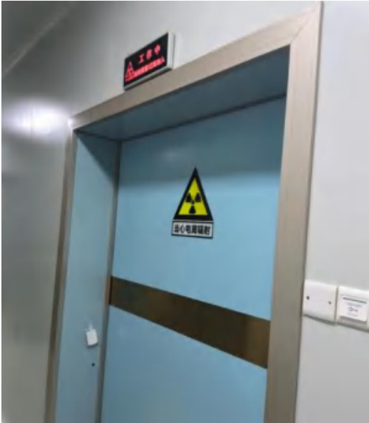
DSA手术室2机房大门闭合
