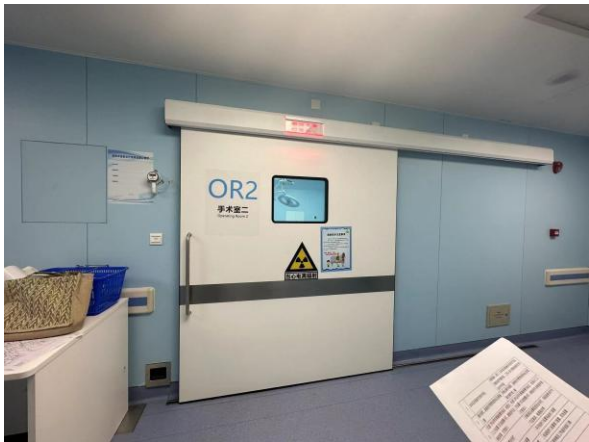
OR2 手术室机房大门闭合状态
