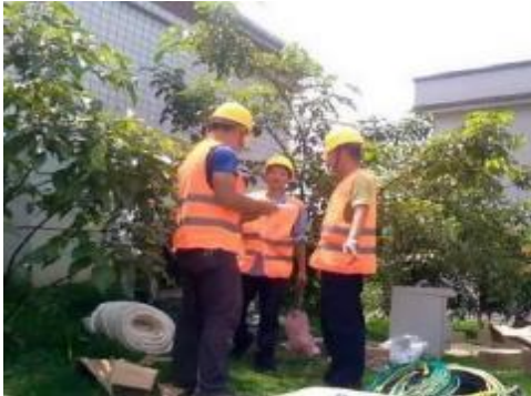
（安装调试前进行安全交底）
