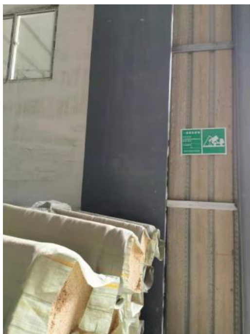
图4-16 一般固废暂存处
