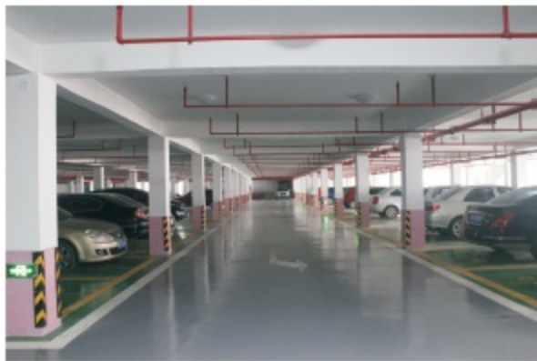
龙岩实小新建校园操场地下室
