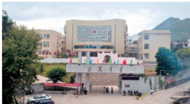
基金会资助建造的学校综合办公楼
