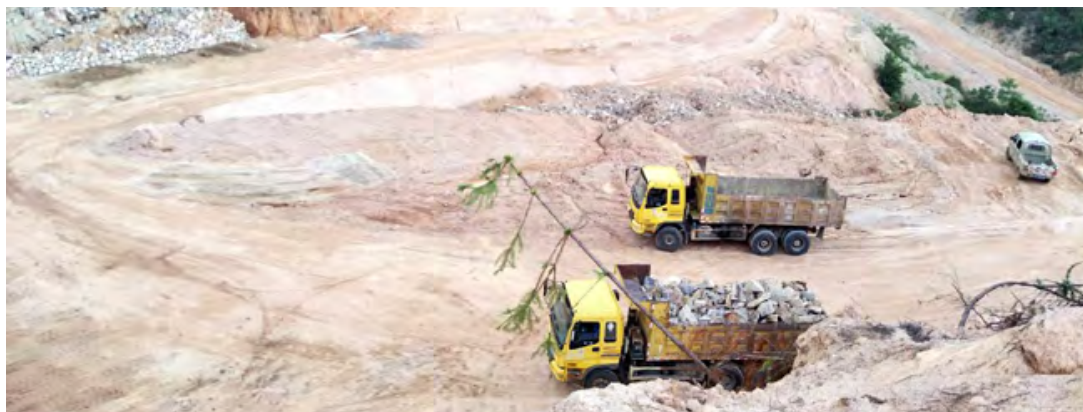
建设中的武平湘店公路
