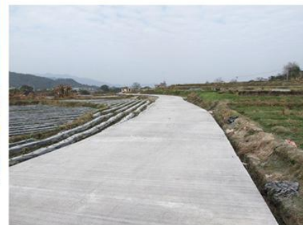
↑ 基金会资助修建的武平县岩前镇大布村村道
