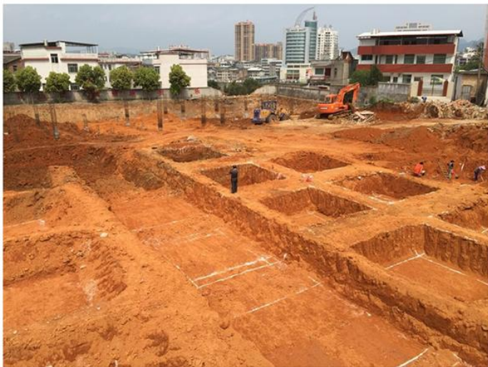
基金会资助的上杭二中体育馆正在施工中
