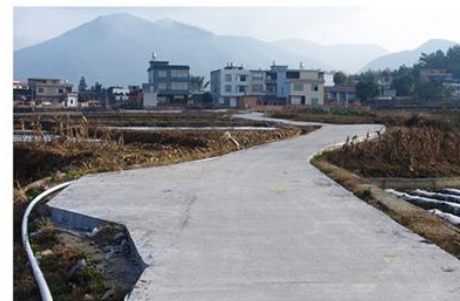
← 基金会资助修建的武平县岩前镇伏虎村道路
