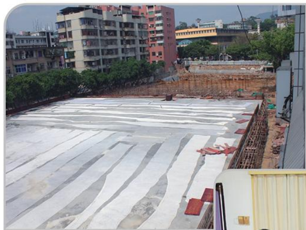
↑ 龙岩实小运动场改造项目在施工中
