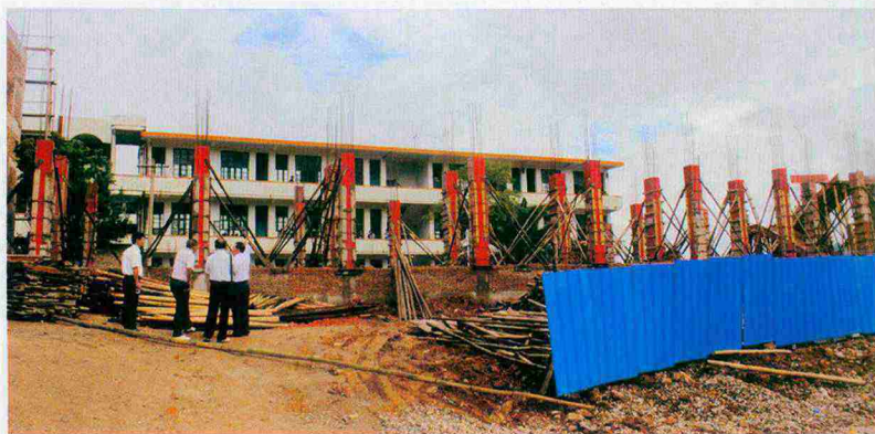
施工中的上杭才溪中学教学大楼
