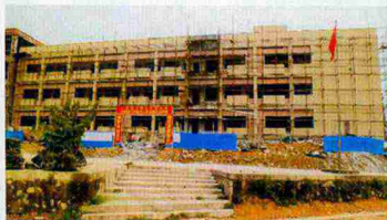
基金会资助的才溪中学教学大楼正在施工
