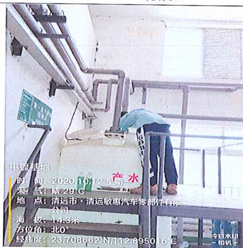
含镍车间废水排放口
