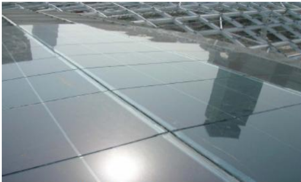
青岛火车站BIPV光伏系统（外视）
