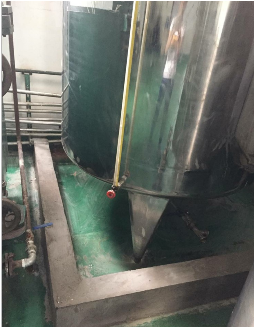
酒精罐区围堰及连接管道
