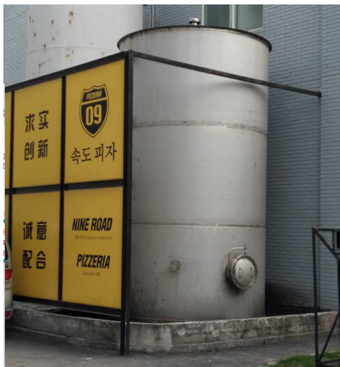
植物油储罐及围堰
