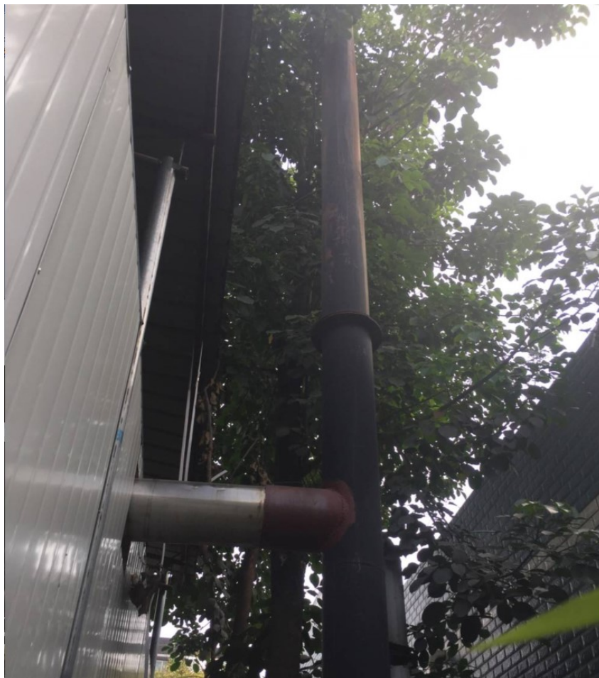
图 3-2 天然气燃烧废气排气筒（8m）
