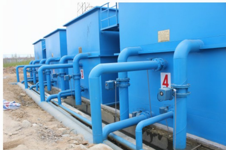
广西博白水利局净水设备(V型滤池)，处理量（40t/h）
