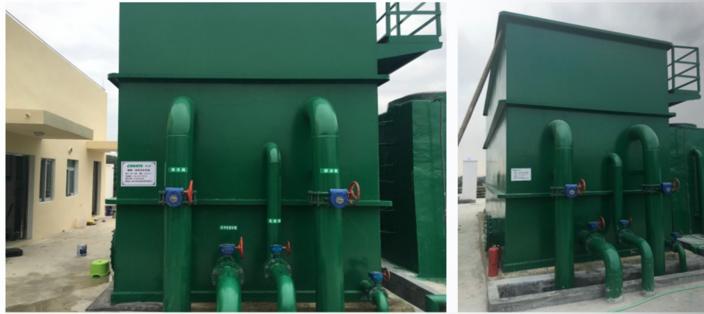
广东陆丰重力式一体化净水设备，处理量（10t/h）
