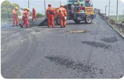
沙港邬家桥位于奉贤区庄行镇，是庄行镇“四好农村路”建设工程——北环路项目的重点桥梁工程，主要对原有旧桥梁进行拆除和吊装专项施工，改造为新桥梁。项目于2025年1月开工，施工期间采取全封闭围挡措施，截至4月下旬，工程已顺利完成沥青砼摊铺。
