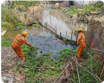
一状况。随即，立刻组织人员准备清淤疏通工作。在确保安全的前提下，工作人员首先对管道进行初步冲洗。高压水流通过喷嘴喷入管道，能够有效冲击和松动管壁上的淤泥和杂物。在高压冲洗的基础上，工作人员又利用手动打捞工具进入管道，仔细打捞沉淀在管壁的淤泥垃圾。随即启动吸污车，将淤泥杂物吸除，水流重新在管道内欢快地流淌，仿佛在诉说着
