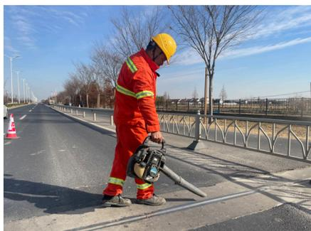
养护作业严格执行《养护作业操作规程》，规范设置安全作业区，引导车辆有序通行。作业人员采用人工方式，使用扫帚、长木棍、铁铲等工具对伸缩缝进行细致清理，并配合吹风机清除残留物，确保无淤泥杂物堵塞。同时，对泄水孔进行疏通，增强桥梁排水能力。
