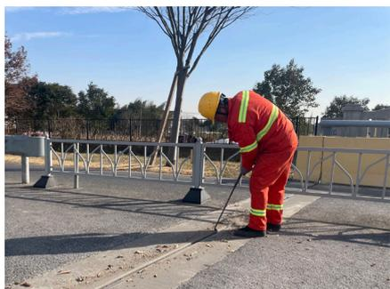
预防为主，防治结合”原则，同步检查桥梁连接部件状况，及时发现并处理松动、脱落、破损等问题，确保桥梁设施功能完好。
