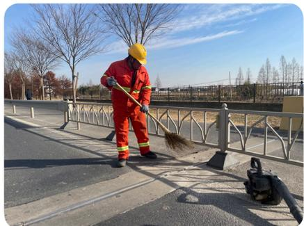
为全面加强桥梁养护管理工作，保障桥梁通行安全。1月，青村道班对辖区范围内的桥梁伸缩缝进行全面清理。
