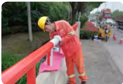
■ 钢护栏面漆涂刷
