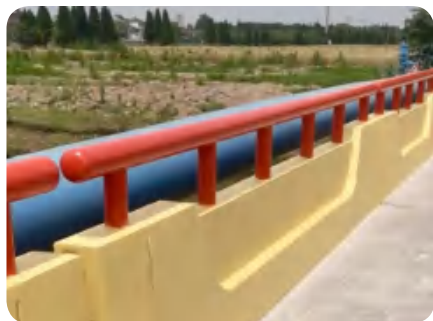
■ 平庄西路南横泾桥
