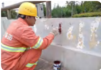
■ 混凝土表面锈涨修复
