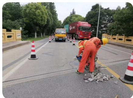
青村道班养护人员道路巡查时，发现航南公路沈家港桥梁伸缩缝处水泥混凝土局部破碎。车辆通过时存在跳车现象，如不及时处理，影响桥梁的使用寿命和道路的正常通行，存在较大的安全隐患。
